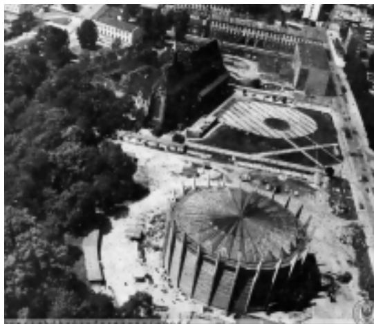
Rotunda Panoramy i plac budowy oraz okolice na początku lat 80.
